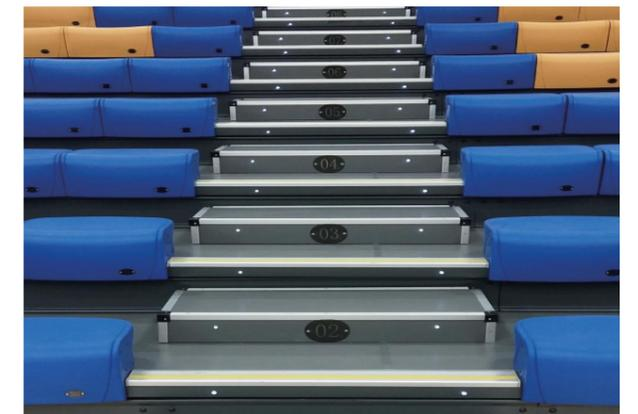
通道做密封处理,用做提醒上台阶时注意安全,踏步高度小于等于200mm,且踏步材料与踏板保持材料风格一致,同时也起到防滑作用
