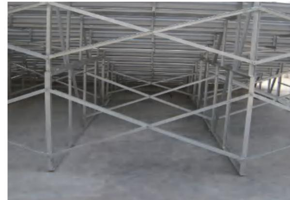
底部结构为采用角钢拼装焊接结构,更科学,与地面形成大面接触,基础要求更低。
