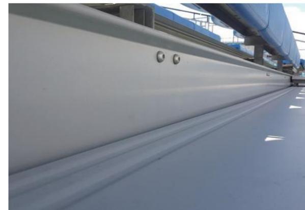
背板折弯一体成型背板,上承下托,能均匀分布看台负载,使整个上部看台强度更高,承载更强,结构更稳定。
