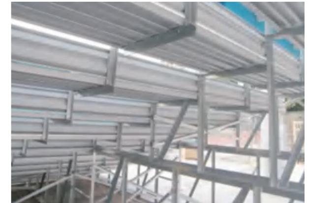
主支撑3656mm标准间距,中间用角钢拉杆连接相邻两跨,整体形成框架结构,稳定性和承载力更强。
